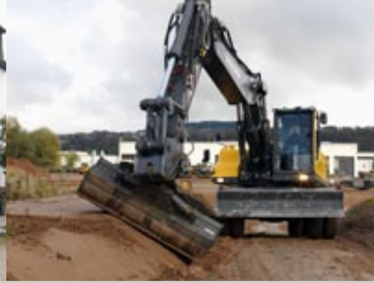
• Sbraccio e potenza per livellare e scavare.
