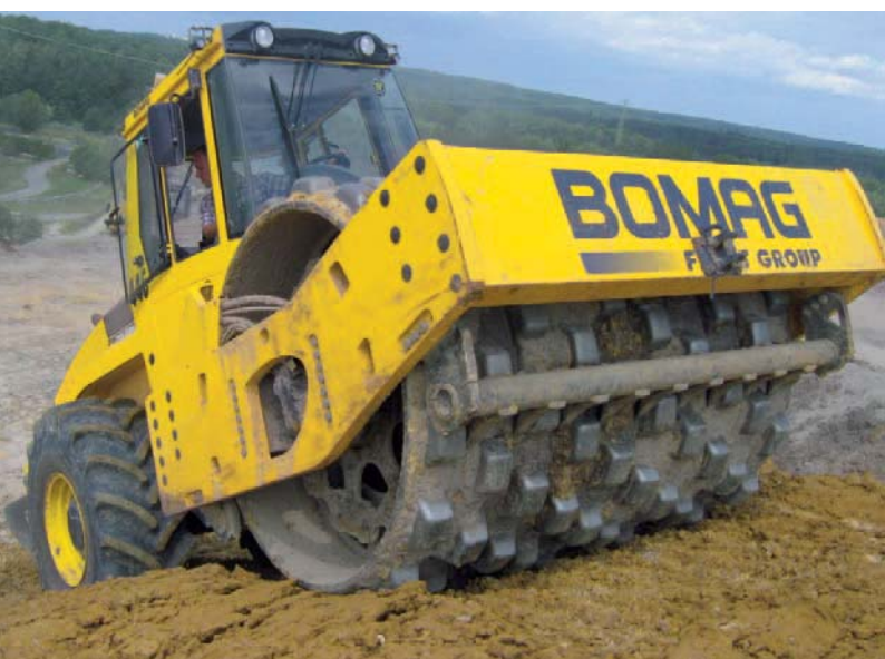
Motore di traslazione DH – fino al 63% di capacità di salita. Qui il BW 219 PDH-4 durante la costruzione di un terrapieno.
