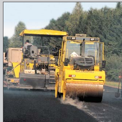
Compattazione di un giunto longitudinale (caldo - freddo): l'ampiezza viene adattata automaticamente.
