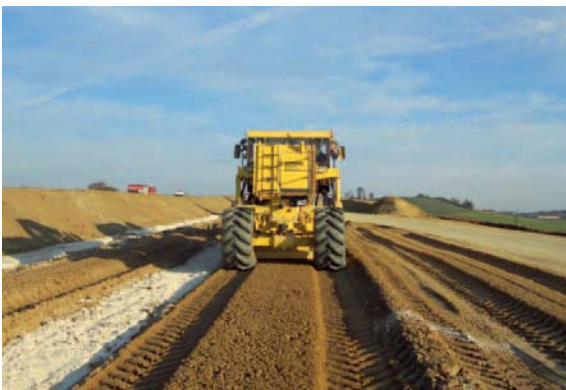
Ottima qualità di miscelazione e realizzazione di strati omogenei – questa è la tecnologia BOMAG FLEXMIX.
