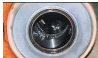
Rivestimento termico WC
