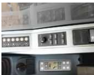
Pannello di controllo centralizzato
