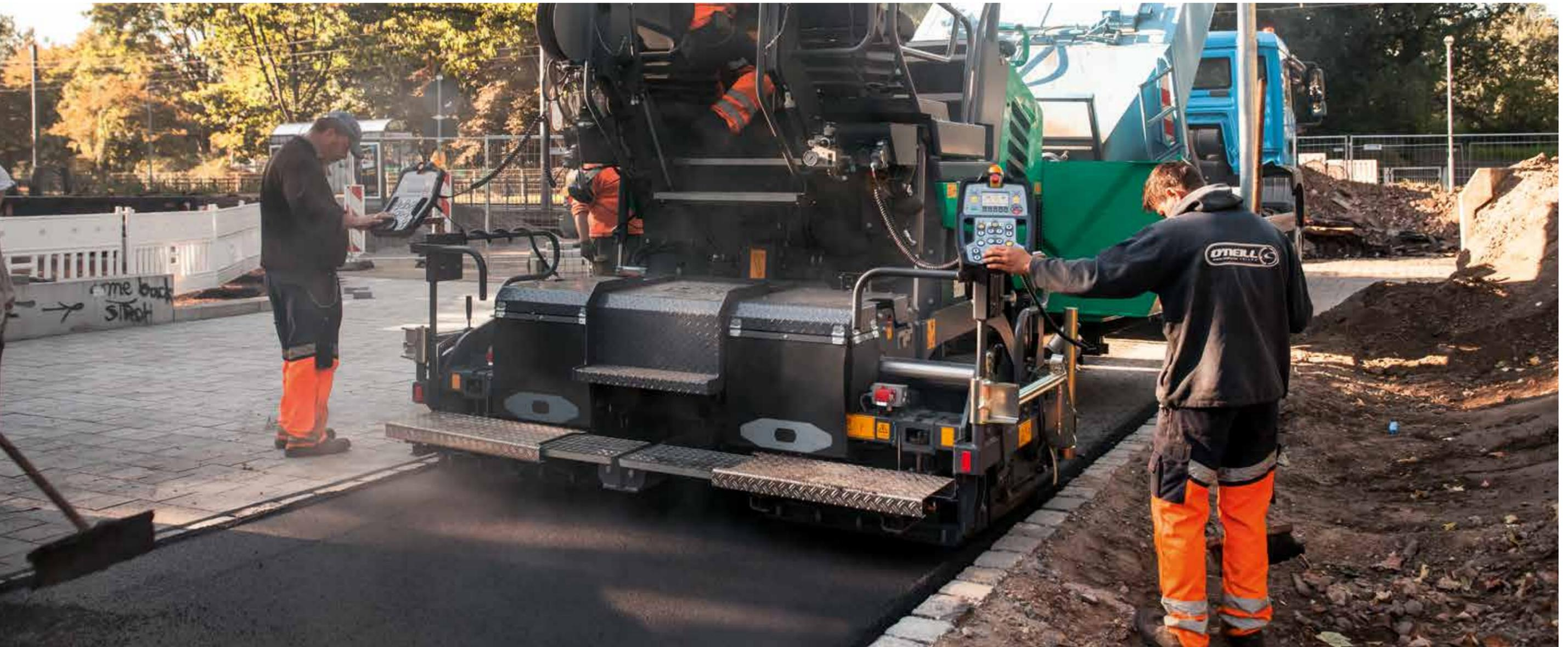
Il banco di stesa AB 340 V si adatta in maniera ottimale ai campi di applicazione della SUPER 1100-3i. Il banco vibrante consente di eseguire gli interventi di ripristino in modo particolarmente rapido e semplice, senza dover rinunciare alla qualità.
