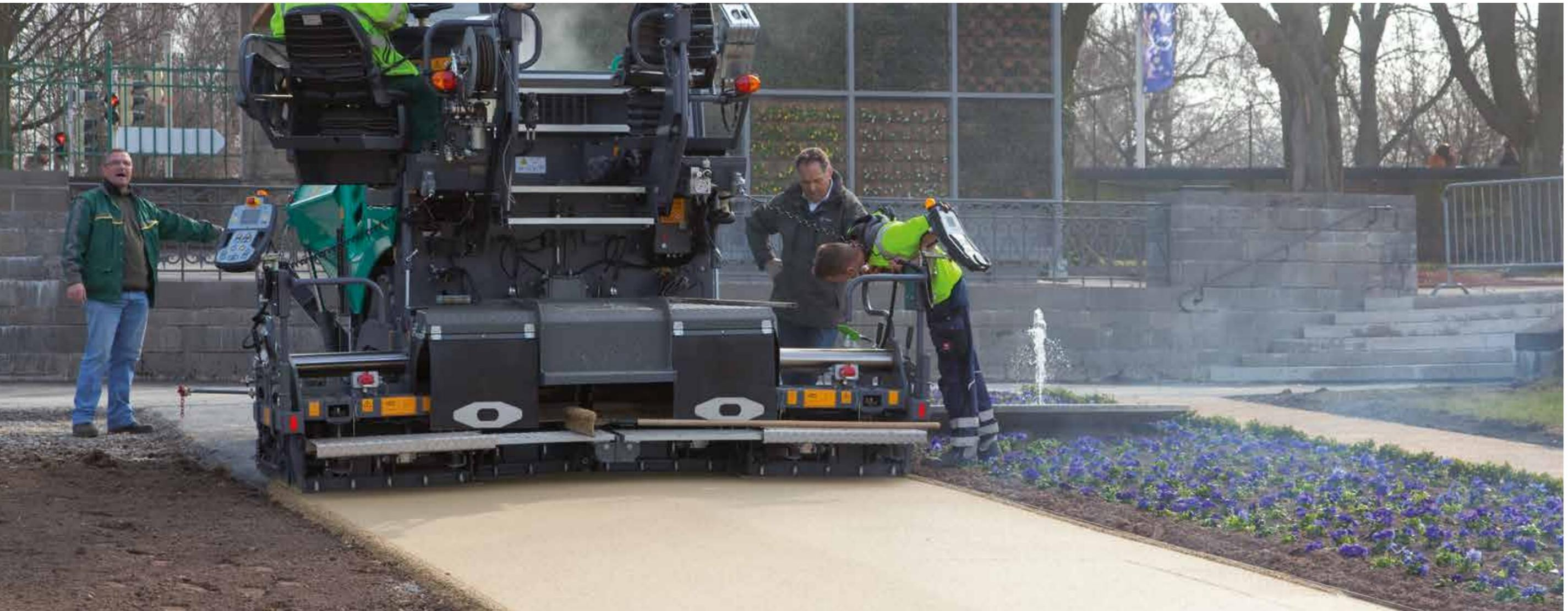
Il banco di stesa AB 340 V si adatta in maniera ottimale ai campi di applicazione della SUPER 1103-3i. Il banco vibrante consente di eseguire gli interventi di ripristino in modo particolarmente rapido e semplice, senza dover rinunciare alla qualità.
