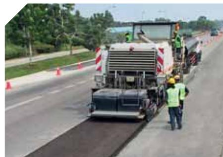
▮ La 2200 CR si presta in maniera ideale al riciclaggio a freddo di pavimentazioni stradali in conglomerato bituminoso ammalorate.
