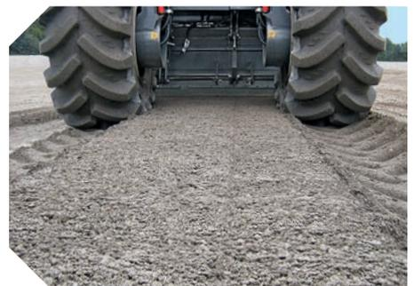
La WR realizza lo strato di fondazione in misto cementato con una qualità di miscelazione ottimale
