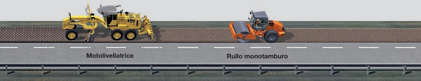
Per la realizzazione di uno strato di fondazione in misto cementato uno spandilegante Streumaster sparge dapprima uno strato di cemento, seguito da un'autocisterna dell'acqua. Il potente rotore di fresatura e miscelazione della WR granula gli strati ammalorati, mescolandovi il cemento e l'acqua iniettata. Mentre una motolivellatrice esegue la sagomatura fine del riciclato omogeneo ottenuto, diversi rulli Hamm provvedono alla sua compattazione.
