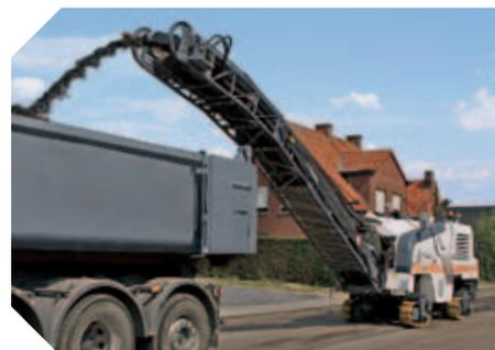
Le macchine sono in grado di scarificare senza problemi interi pacchetti di pavimentazione ▲
