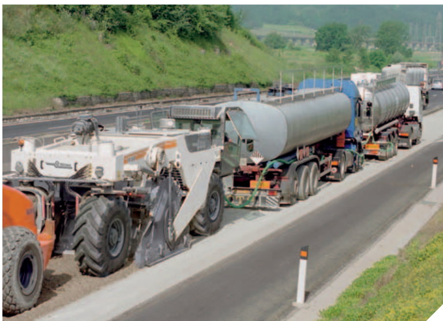
◀ Riciclaggio di corsie autostradali
