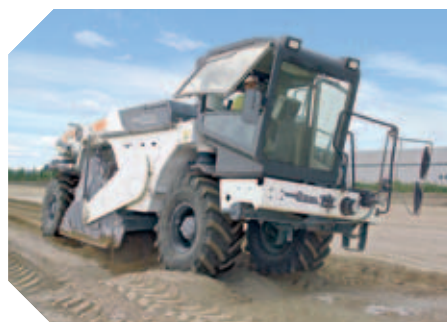
Stabilizzazione del terreno con cemento per nuove aree commerciali e industriali ▲
