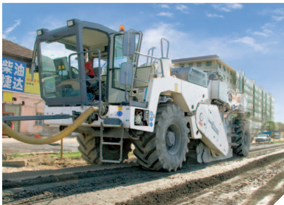
▲ Cina: costruzione di una nuova strada urbana
