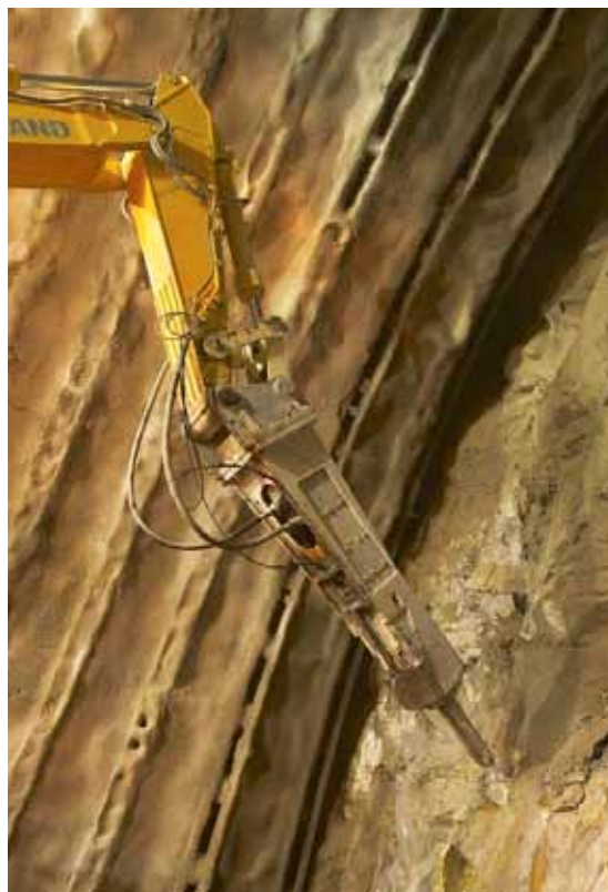
Martello Indeco sul fronte di scavo
