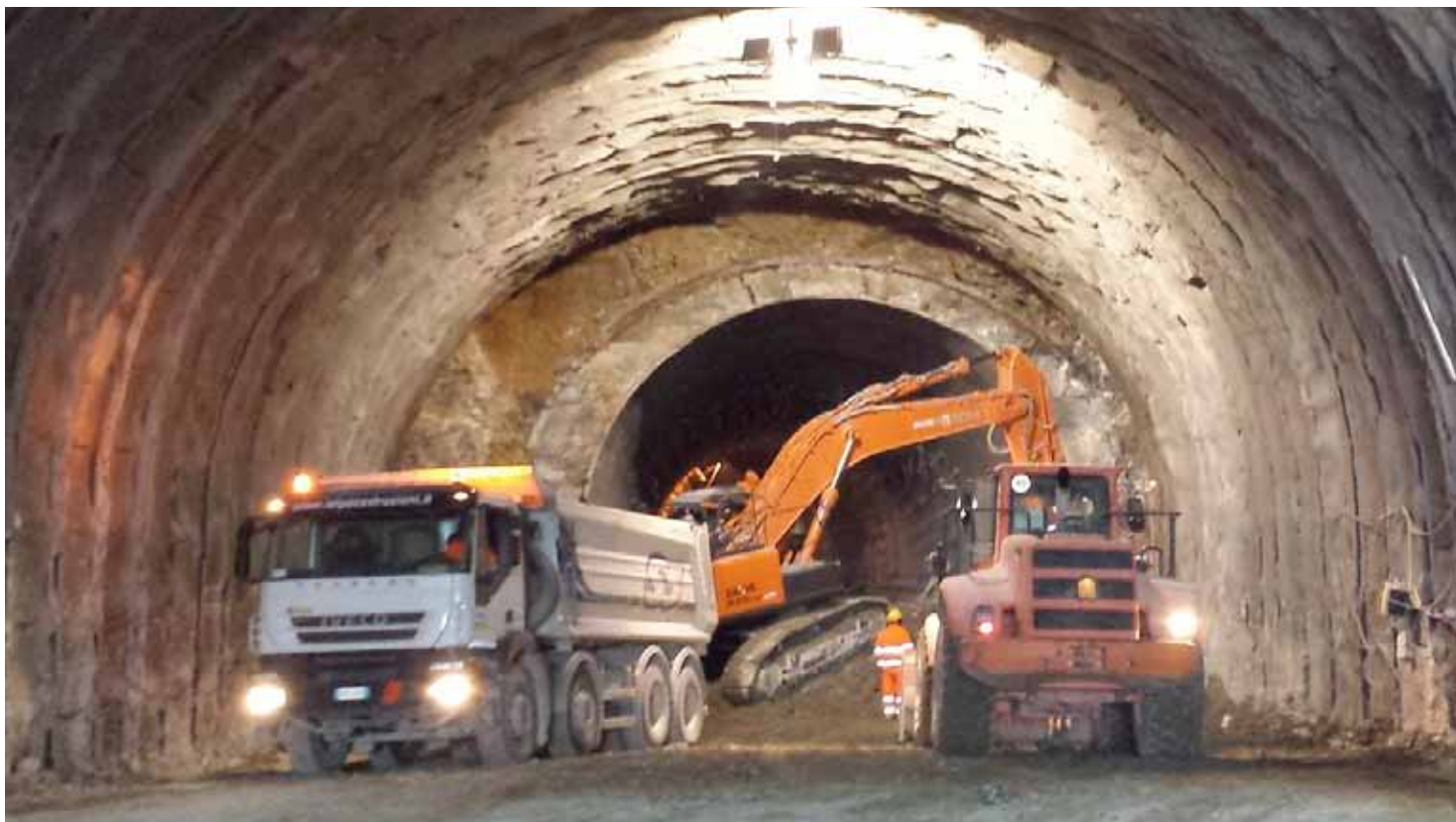
Scavo parziale di allargamento galleria, A3 SARC Normanno, HP 7000 su Hitachi 470
