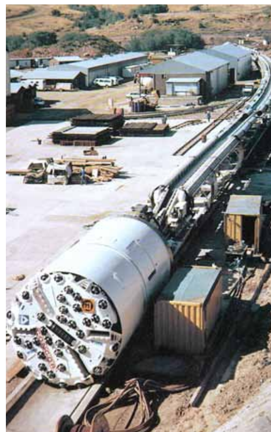
Utilizzo TBM nel progetto idrico Lesotho Highlands (Tambo_CC BY-SA)
